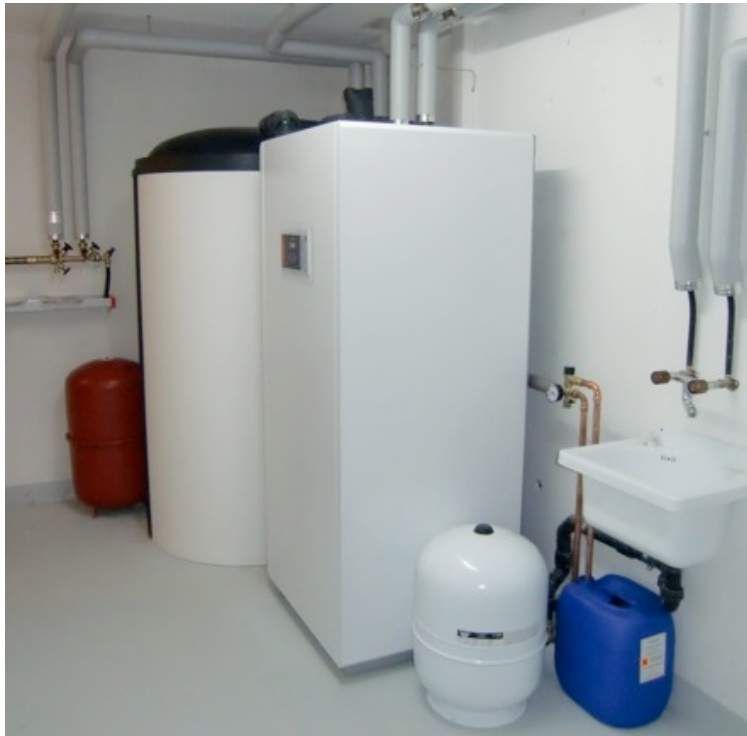
Abbildung 1: SOLAERA-Energiezentrum mit Solar-Kombispeicher als kompakte, komplett vormontierte und vollständige Wärmeversorgung
