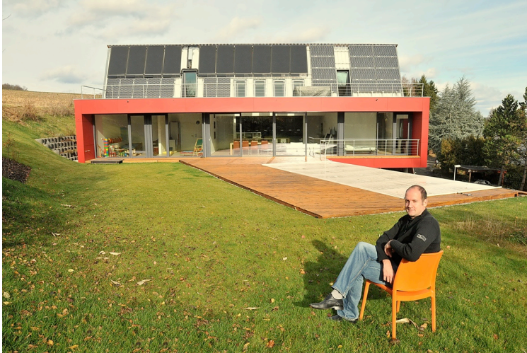
Abbildung 7: Mit SOLAERA und PV versorgter Neubau
