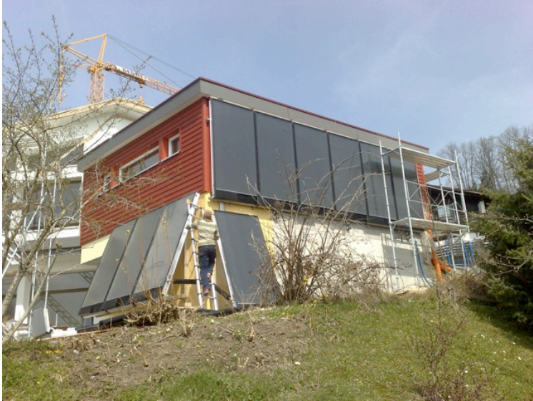
Abbildung 3: Objekt mit 2 unterschiedlich ausgerichteten SOLAERA-Hybridkollektorflächen
